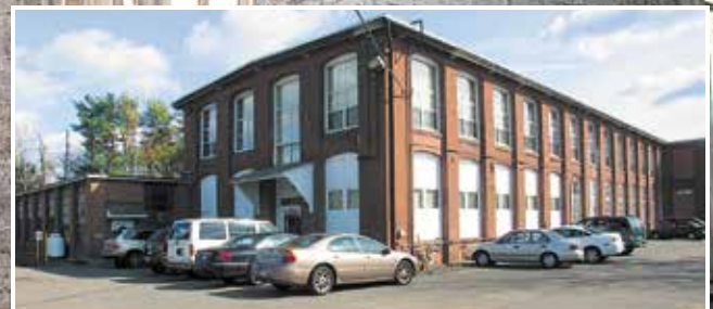
Bâtiment Remington Rand rénové, à Middletown, Connecticut
