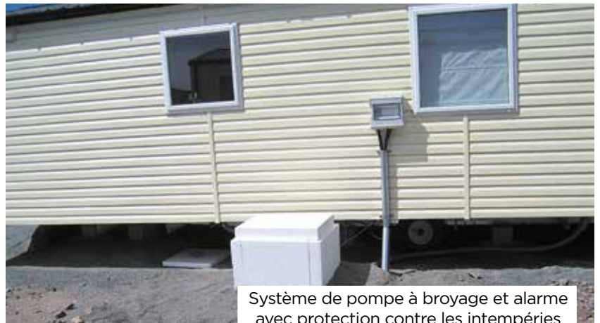
Tuyau d'évacuation d'une remorque, raccordé au système Sanicubic 1
