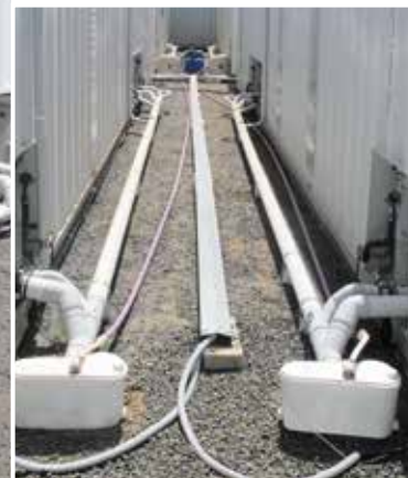
Les unités Sanibest Pro pompent les déchets broyés jusqu'à 100' horizontalement
