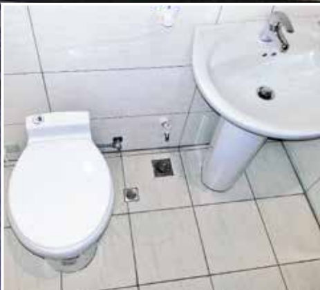
Lavabo raccordé au système de toilette et pompe de macération Sanicompact
