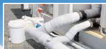
Les appareils sanitaires d'une salle de bains complète sont évacués dans le Sanibest Pro
