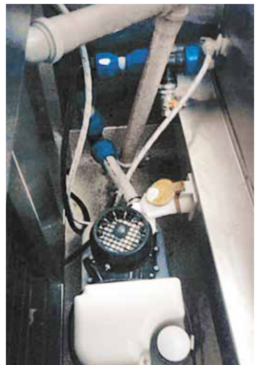
Installation de la pompe derrière le four
