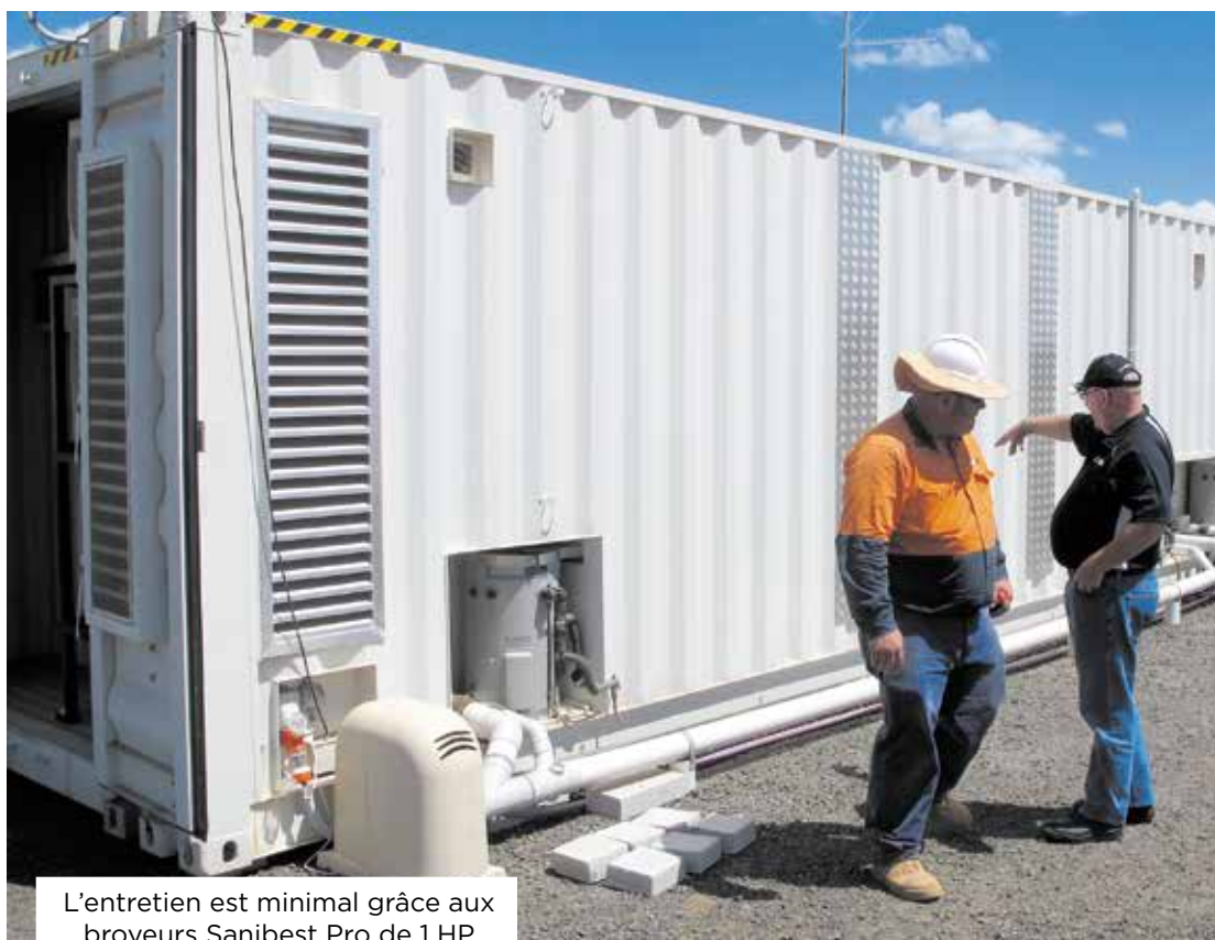
Les unités Sanibest Pro pompent les déchets broyés jusqu'à 100' horizontalement
